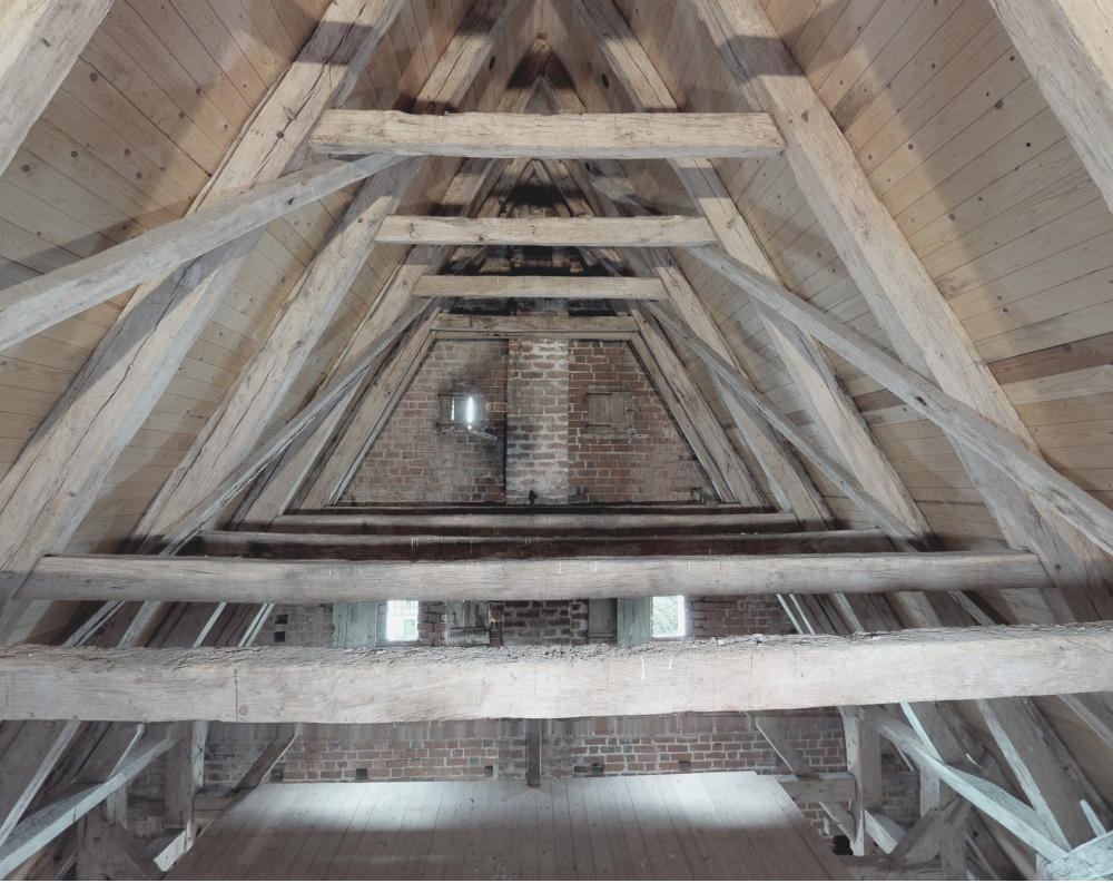
Det komplicerede bindingsværksloft på Hesselagergård, som R3DA bl.a. har 3D-scannet.
